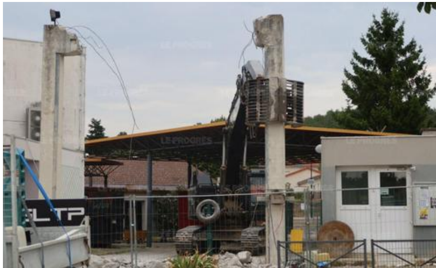
Le projet de rénovation du site scolaire des Brosses est entré dans sa phase opérationnelle avec la déconstruction du bâtiment ouest. Photo Lionel Francois
